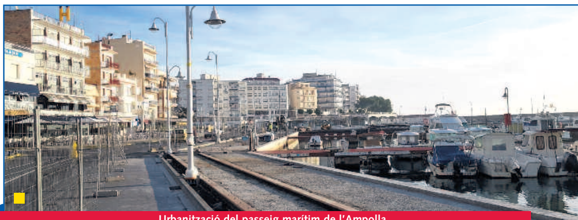
Urbanització del passeig marítim de l'Ampolla
