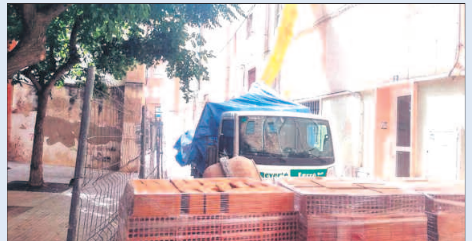
L'AJUNTAMENT DE LA RÀPITA posa en marxa les obres del Casal d'Entitats a l'edifici del carrer Convent. Els treballs han estat adjudicats a Construccions Reverté Ferré per 167.542 euros.
