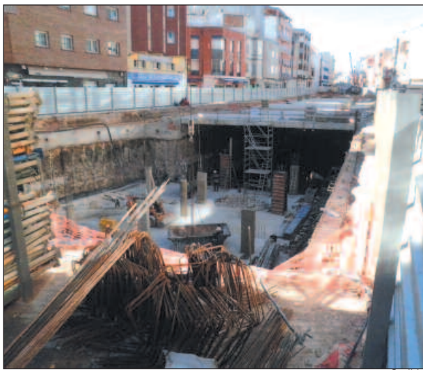
Imatge de les obres.
