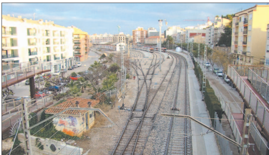
El mal estat de les instal·lacions de l'estació de Tortosa és evident.
