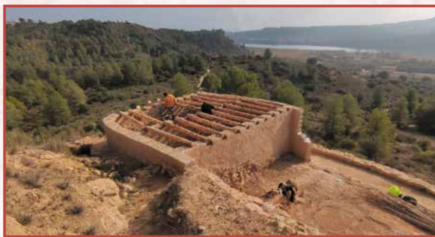
Treballs d'adequació del jaciment protohistòric de Sebes.
