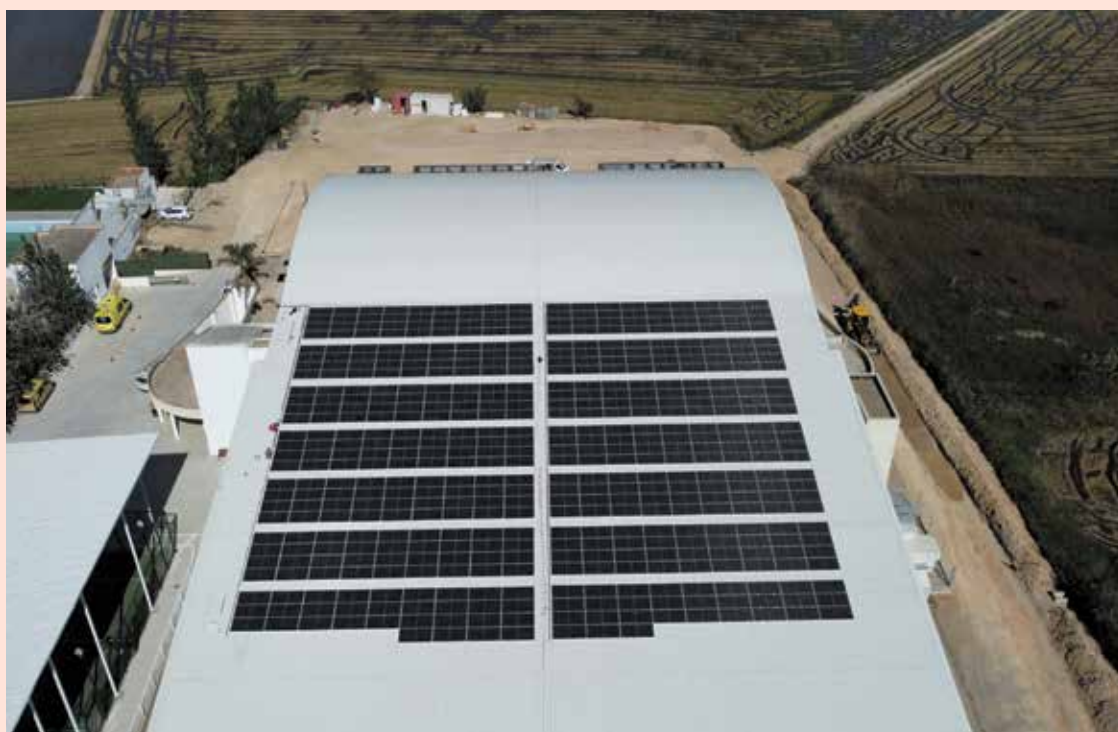
Imatge on es veuen algunes de les plaques fotovoltaïques que l'Ajuntament de Deltebre ha instal·lat en 7 equipaments municipals. Les Plaques suposaran un estalvi econòmic net de més de 180.000€
