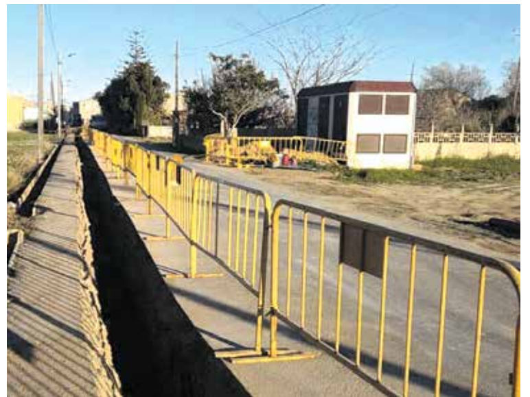
Imatge d'arxiu de l'inici dels treballs de soterrament de la línia elèctrica.
