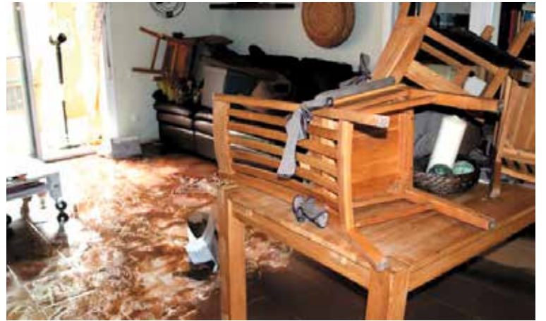
Interior d'un habitatge de Serramar, després del temporal del 2018.
