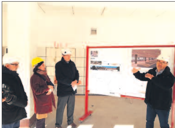
Visita a les obres, aquesta setmana.
