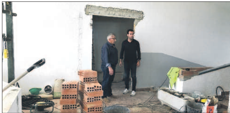
Visita a les obres, aquesta setmana.
