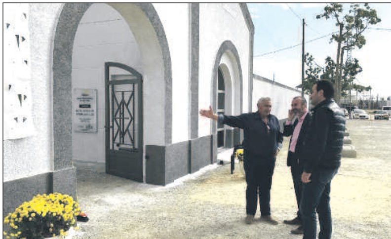
Visita a les obres, aquesta setmana.
