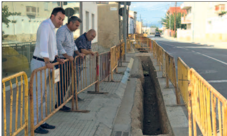
Visita a les obres.
