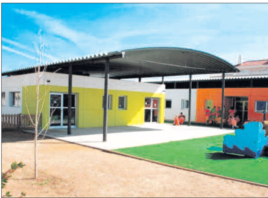
Escola bressol municipal Xip Xap, a la Ràpita.
