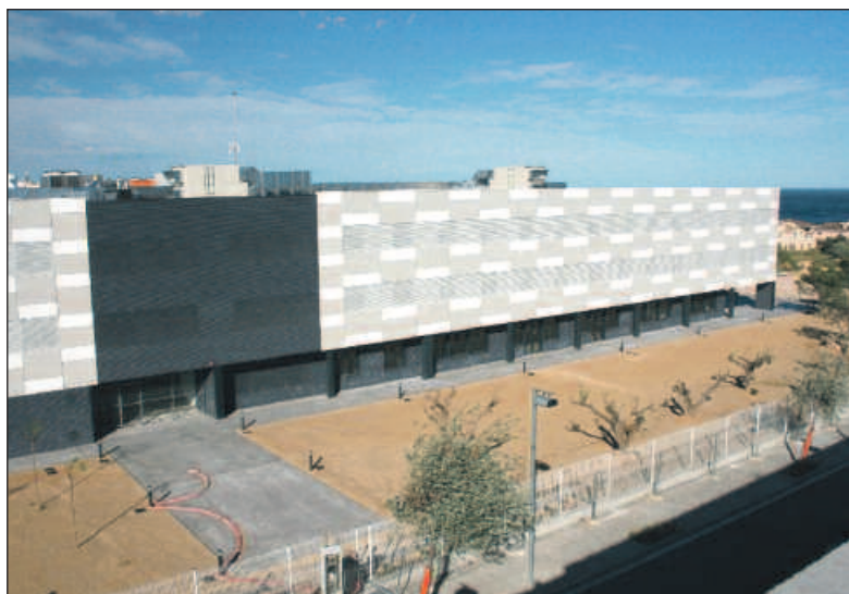
Façana de la residència d'avis de la Cala.
