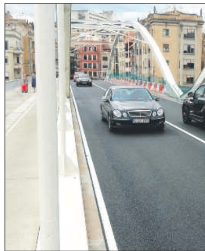
Pont de l'Estat de Tortosa.
