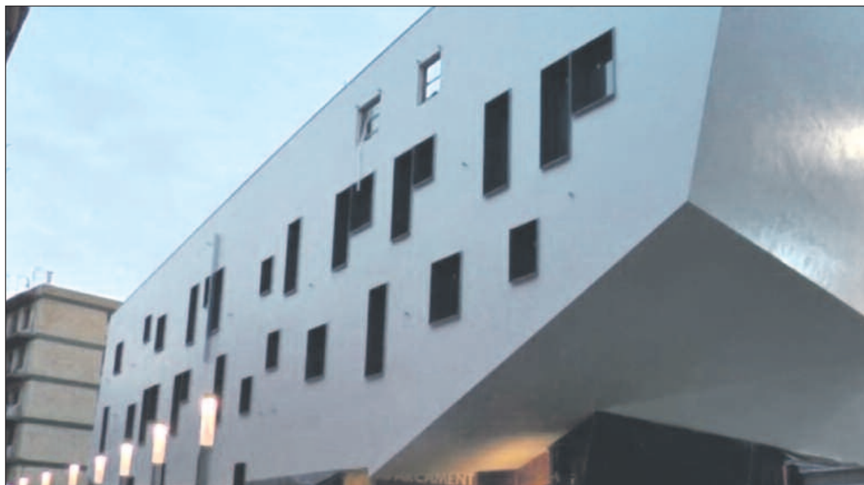
L'Edifici de la Generalitat a les Terres de l'Ebre s'inaugura aquest matí.
