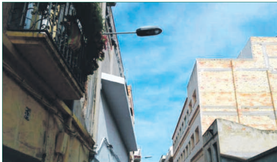
● Nou enllumenat que s'ha instal·lat a la Ràpita.
