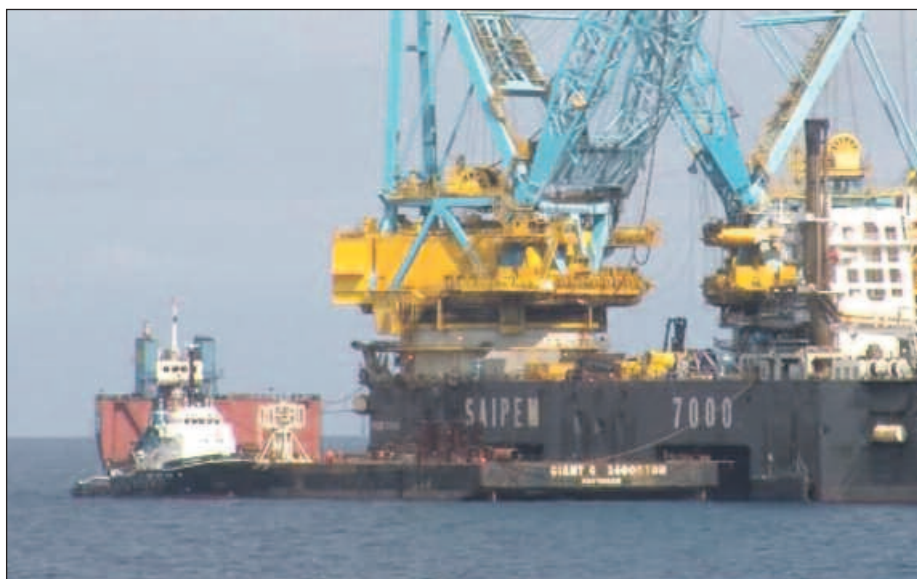
► Instal·lacions del projecte Castor.
