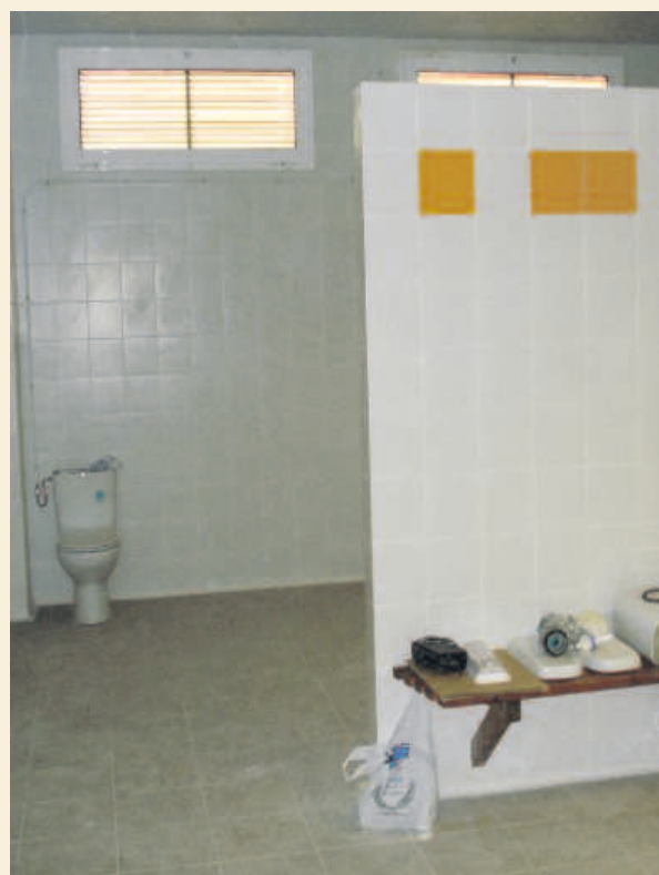
Renovació dels vestidors del pavelló, que ja s'està efectuant.
