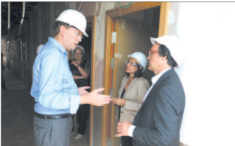
Visita, aquesta setmana, a les obres de L'Onada Tortosa, al barri de Sant Llàtzer.
