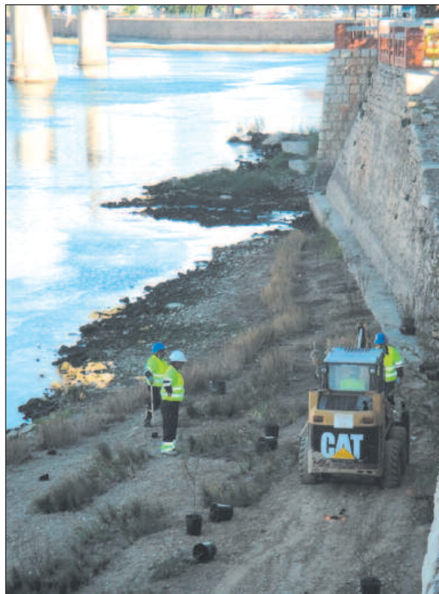
Imatge d'arxiu de les obres.
